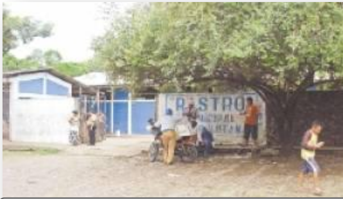
Fig. 8 Fachada del Rastro Municipal de Usulután
