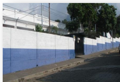
Fotografía # 31 Centro escolar.
