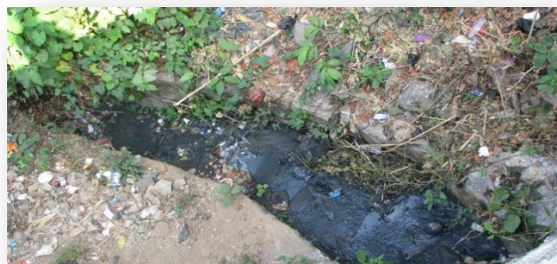
Fotografía # 69 Desalojo de agua negras.
