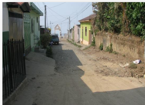
Fotografía # 60 Vía no pavimentada.
