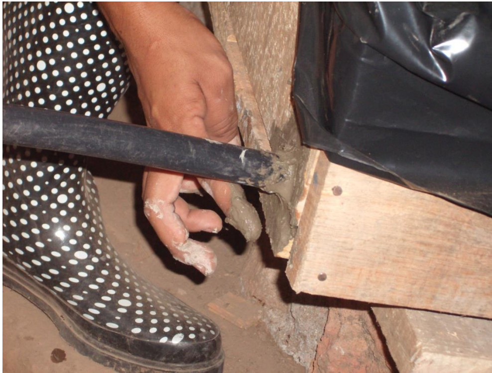
Figura 2. Colocación del tubo para la recolección del purín. Cantón San Juan de Merinos, Municipio Apastepeque, Departamento San Vicente 2008.
