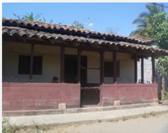
FOTO 25 Vivienda construida de bloque.
