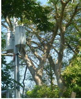
FOTO 17 Poste de electricidad
