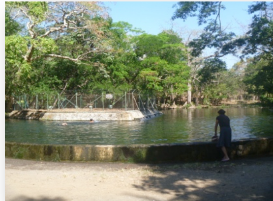
FOTO 18 Piscina de Agua Natural y Planta de Bombeo de Agua Potable.
