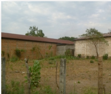
FOTO 24 Construcción de Ladrillo de barro cocido.
