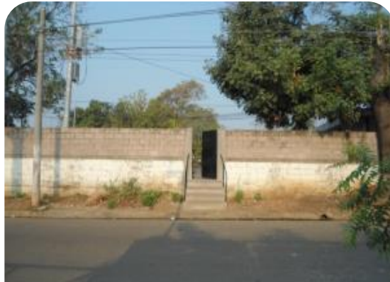
Fotografía 7: puerta de acceso este
