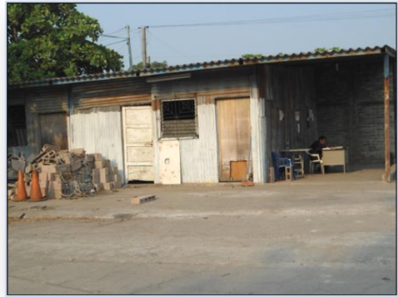
Fotografía 1: area destinada a la recepcion
