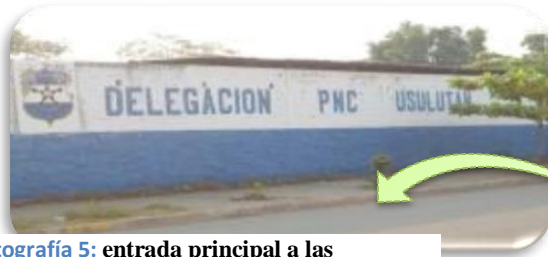
Fotografía 5: entrada principal a las instalaciones
