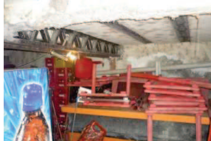
Fotografía N°38 Vista de la losa del sótano
