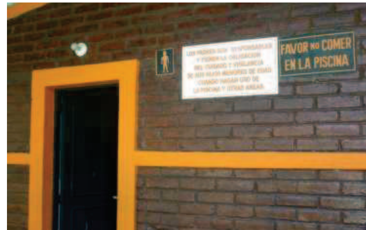
Fotografía N°45 Vista exterior de los vestidores de hombres
