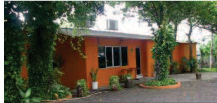
Fotografía N°17 Vista exterior de la administración
