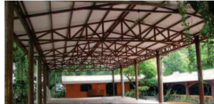
Fotografía N°24 Vista del salón aguilucho
