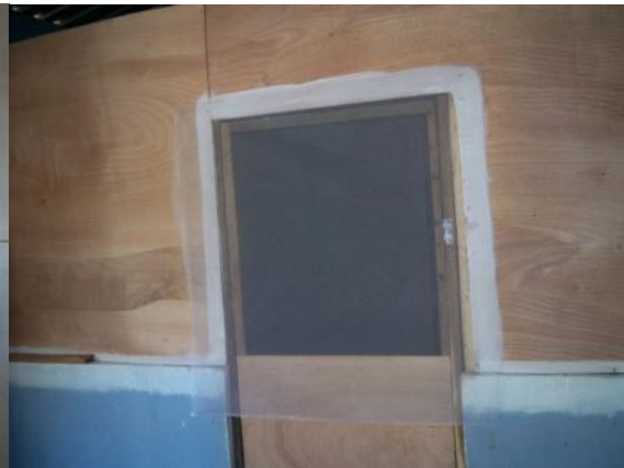
Imagen 6. Cubierta en las ventanas y puertas con malla de tela color blanco para evitar la entrada de de dípteros
