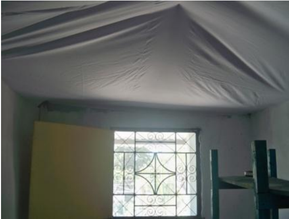
Imagen 7. Colocación de cielo falso de tela color blanco.
