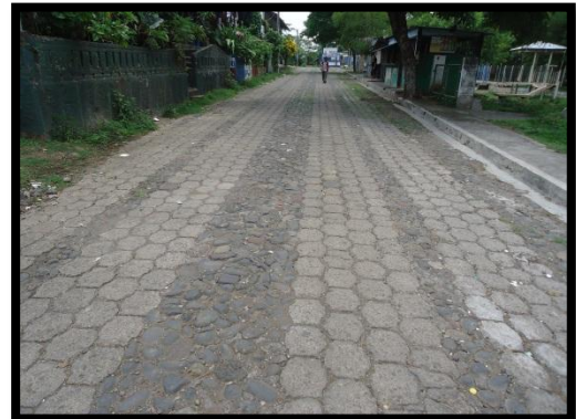
Calle de adoquín y piedra img. 19
