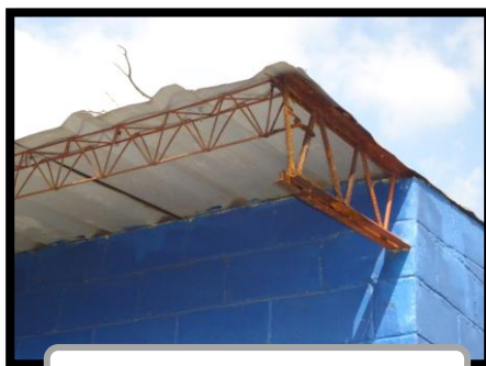
Oxidación en v.c. img. 50
