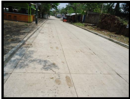
Calles de concreto hidráulico img. 21
