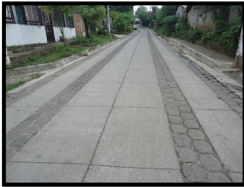
Calles a base de materiales mixtos; concretos y adoquín img. 18
