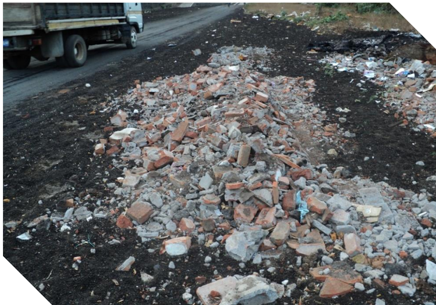
Fotografía 1. Quebrada del Municipio de San Jorge, Departamento de San Miguel; en la imagen se observa desperdicios de demoliciones, que consiste principalmente en mampostería de ladrillo de barro, el desperdicio provocara disminución del área hidráulica en la quebrada.
