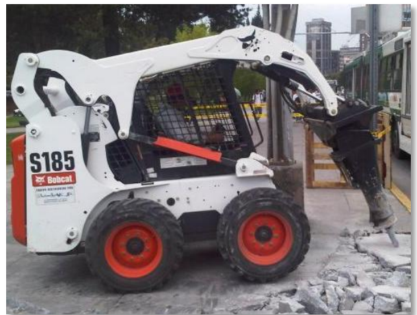
Fotografía 5. 3 Maquinaria utilizada para demoler pavimentos de concreto; martillo hidráulico adaptado a minicargador.
