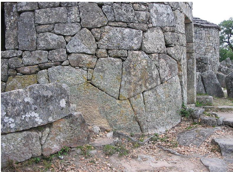
Figura 2.2b. Detalle de sillería en muro de vivienda.
