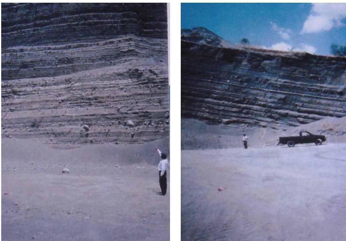
Figura 3.5.1. Secuencia de cortes verticales de entre 15 a 20 metros en los cuales se observa poca cohesión de las partículas Fuente: Diagnóstico ambiental de la laguna de Aramuaca y su entorno. Año de estudio 2011
