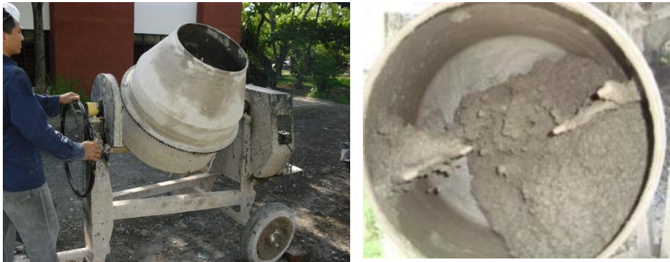
Figura 4.2.1b Colocación de los agregados en la mezcladora mecánica.
