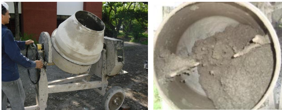
Figura 4.2.2b Colocación de los agregados en la mezcladora mecánica.
