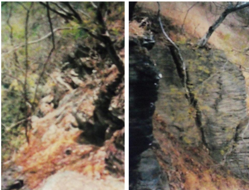
Figura 3.4.3. Ubicación de afloramientos de lavas laminares diaclasadas y meteorizadas, ubicadas en el sector noreste, sobre la cota 105 msnm con espesores aproximados de 30 cm.
