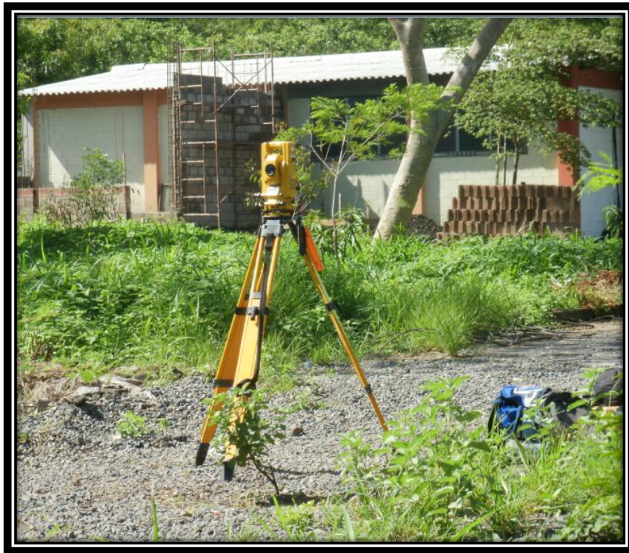
Figura 5.25 Centrar la Estación en el terreno donde se trazará
