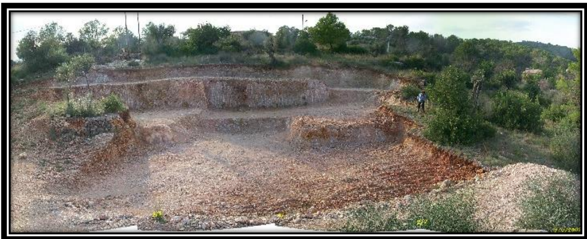
Figura 5.1 Excavación de la planta de un edificio trazado.
