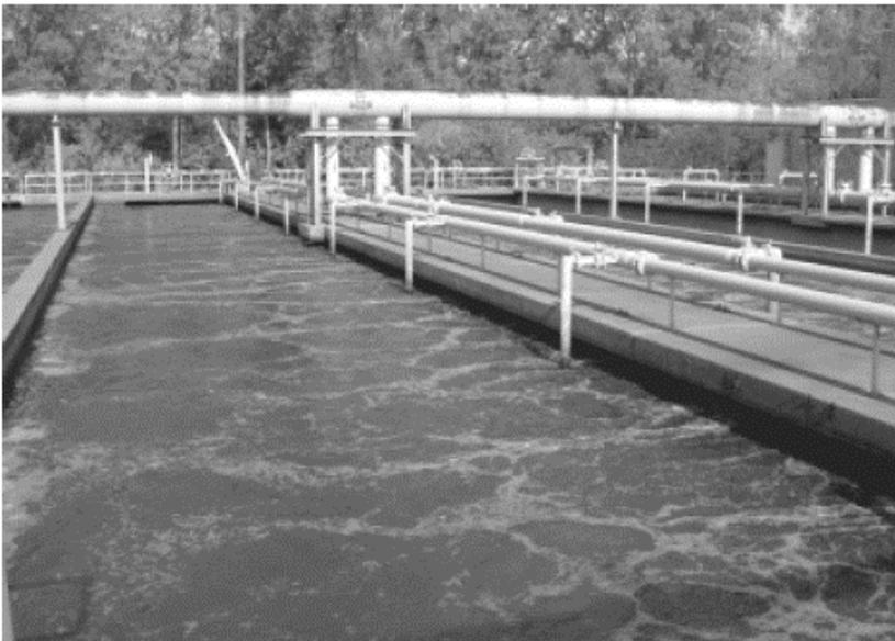
Imagen 22 Tanque de aireación de lodos activados
