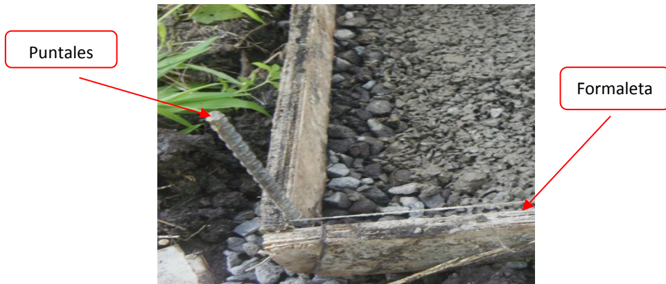
Ilustración 102 Encofrado y Puntales en Losa
