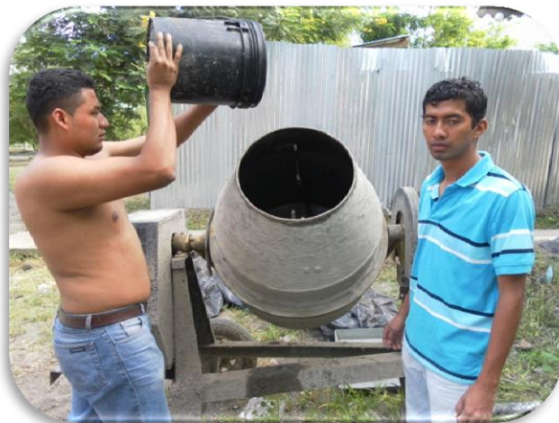
Ilustración 80 Fig. 3.15 a y 3.15 b Elaboración de Concreto
