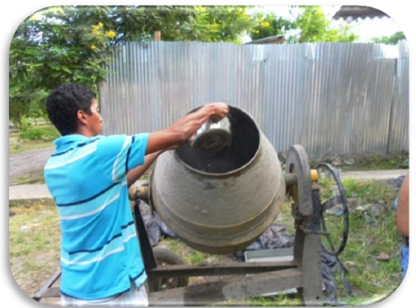
Ilustración 80 Fig. 3.15 a y 3.15 b Elaboración de Concreto
