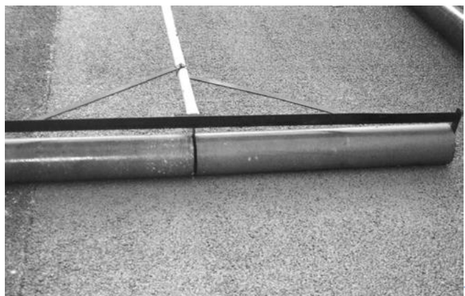
Ilustración 56 Fig. 2.56 Rodillo Secundario usado para la cruz de laminación del concreto permeables para mejorar la calidad de conducción de la acera
