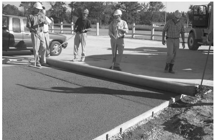
Ilustración 55 Fig. 2.55 Uso de Rodillo Liso para dar acabado final al concreto
