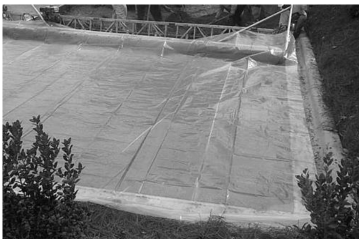
Ilustración 60 Fig. 2.60 Demostracion de curado con lamina plásticas después de compactación.
