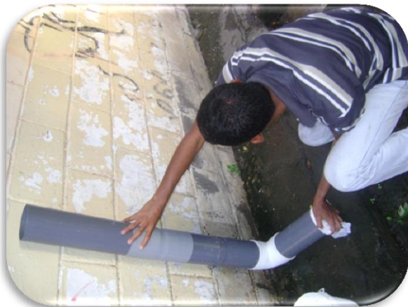
Ilustración 92 Cilindros de Concreto Sometidos a la Prueba de Infiltración
