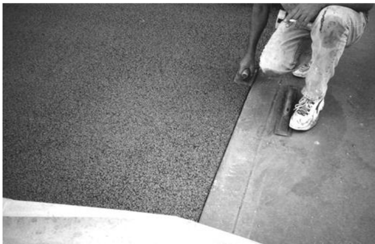
Ilustración 57 Fig. 2.57 Borde de concreto permeable para mejorar la apariencia de las esquinas.
