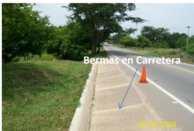
Ilustración 49 Fig. 2.49 Bermas en Carreteras
