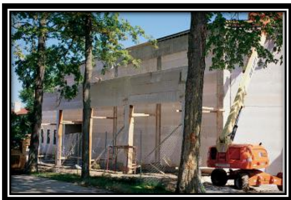
Ilustración 31 Fig. 2.31(Izquierda) Edificio residencial construido con bloques de concreto celular auto-clavado. (Derecha) Bloque de concreto celular auto-
