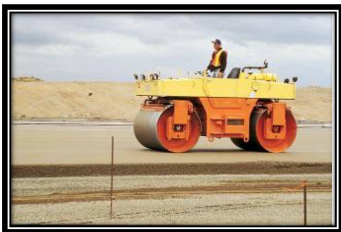
Ilustración 35 Fig. 2.35 Los rodillos vibratorios se usan para compactar el concreto compactado con rodillos.
