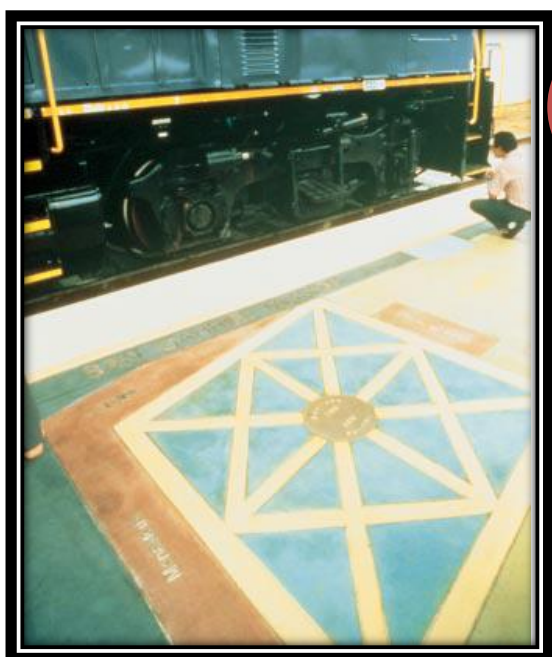
Ilustración 38 Fig. 2.38 Concreto coloreado usado en una plataforma de tránsito rápido.
