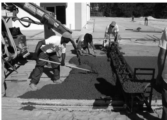
Figura 2.53 Uso de regla vibratoria de enrasado el concreto permeable
