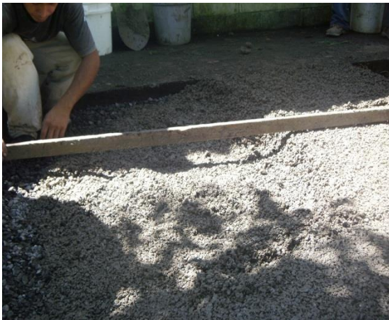
Ilustración 105 Enrasado de Concreto
