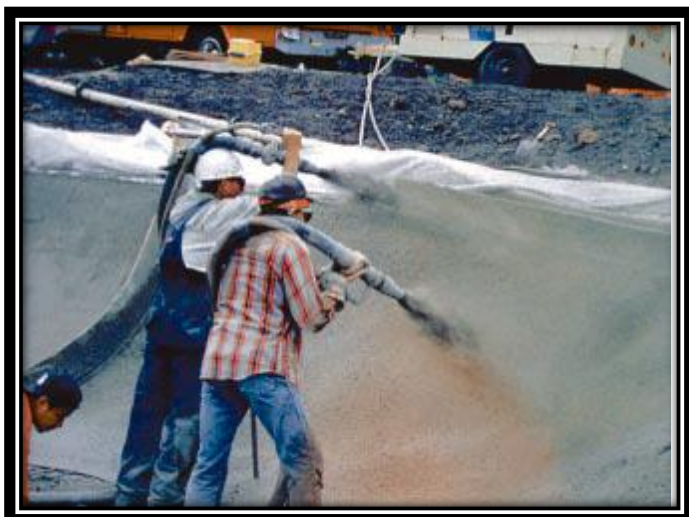
Ilustración 36 Fig. 2.36 Concreto Lanzado
