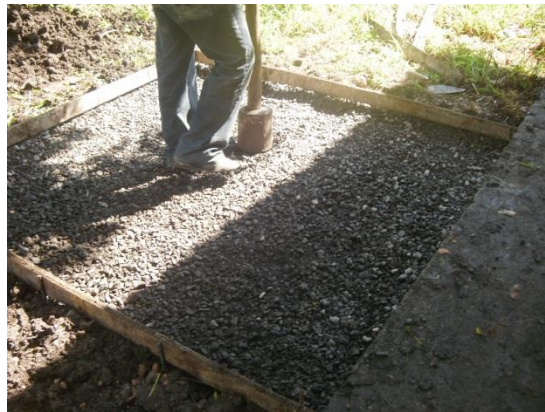
Ilustración 101 a, b y c Compactación de Material Granular
