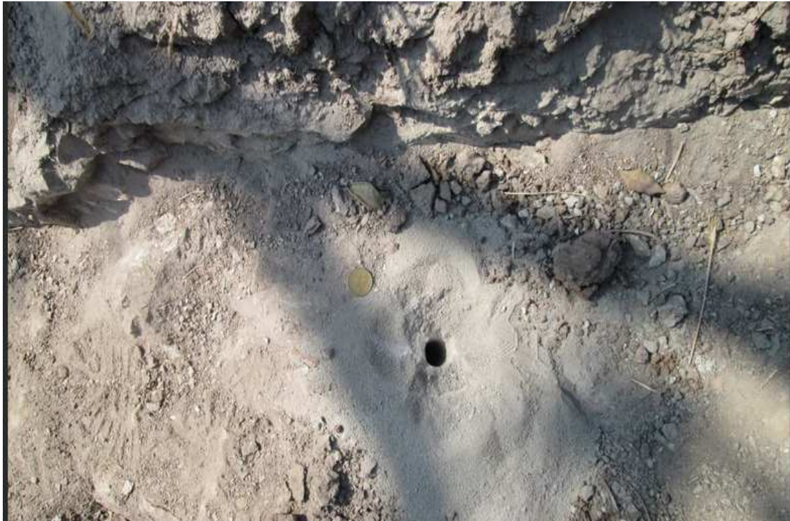
Figura3.47 Perforación culminada y lista para cargar con ANFO.
