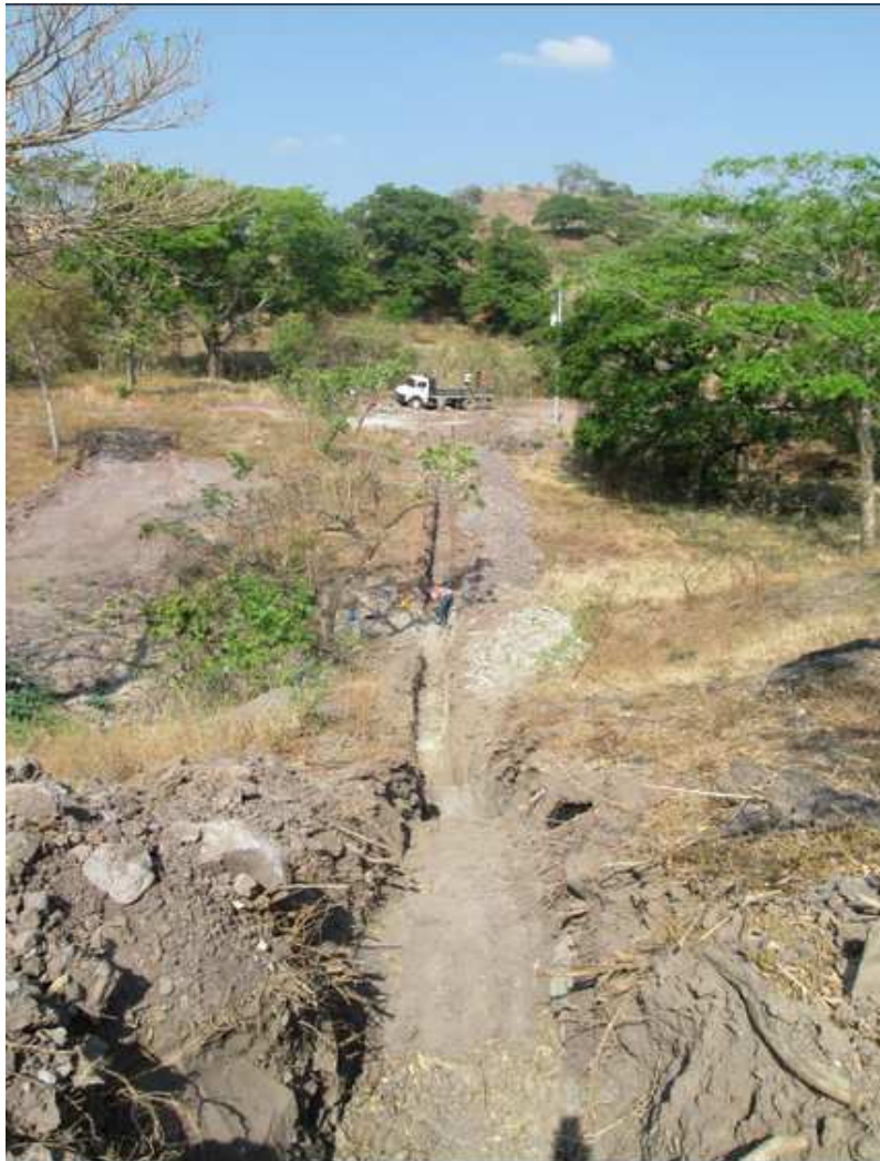
Figura3.44 Lugar donde se utilizara los explosivos para fragmentar estratos de lecho rocoso
