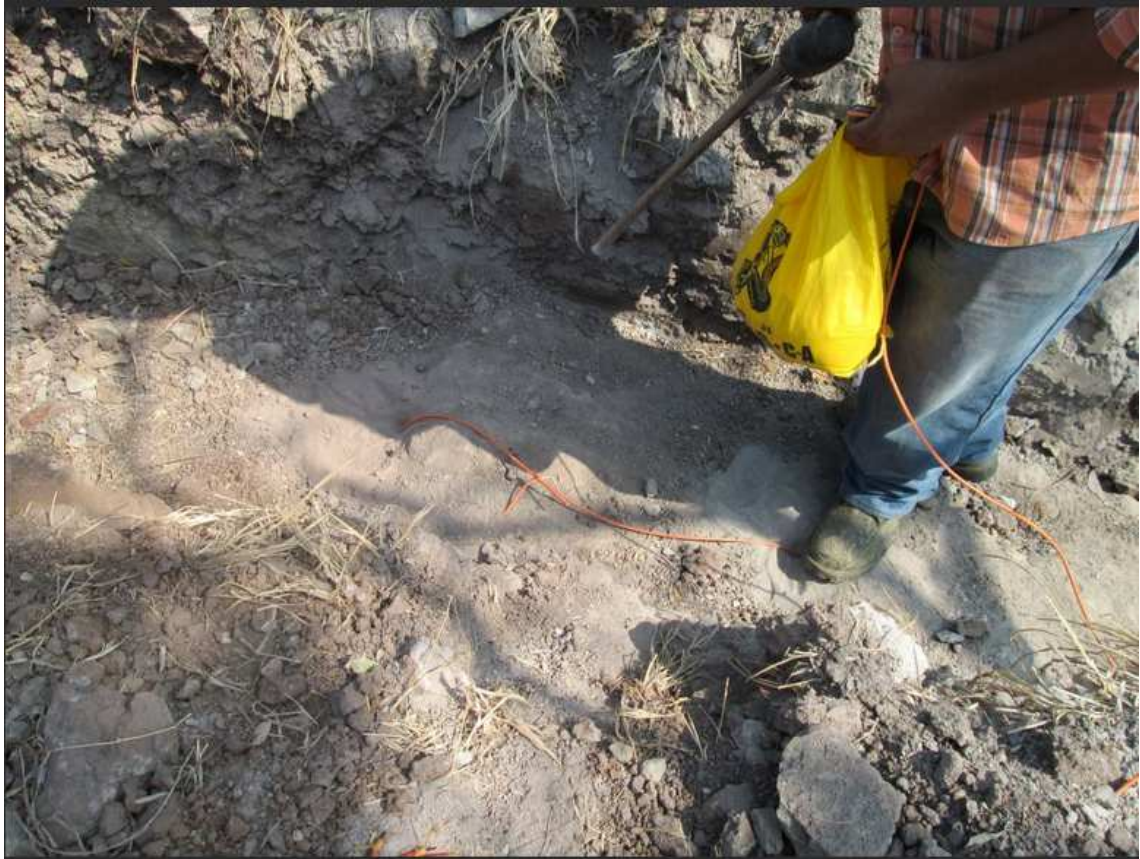
Figura3.50 Colocación de ANFO más armada.
