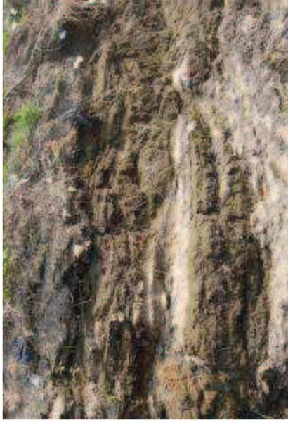
*Talud compuesto de suelo arenoso y basura*
