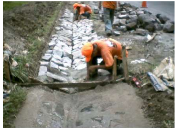
Figura 2.13 Construcción de canaletas.
