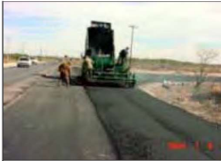
Figura 2.15 Colocación de carpeta asfáltica.
