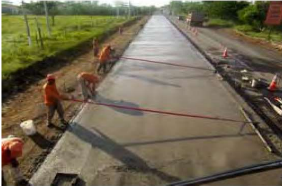
Figura 2.15.- Rehabilitación de Pavimentos.
