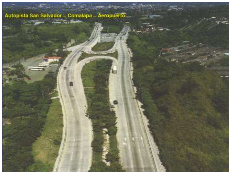
Figura 1.3 Autopista San Salvador-Comalapa-Aeropuerto.
