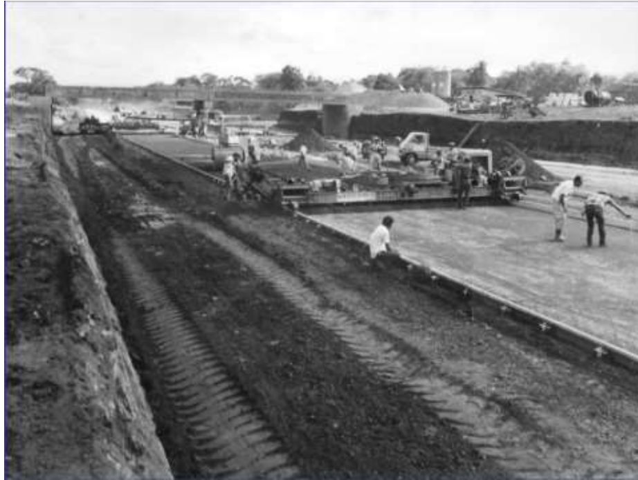
Figura 1.2 Pavimentación en El Salvador en la década de 1970.
