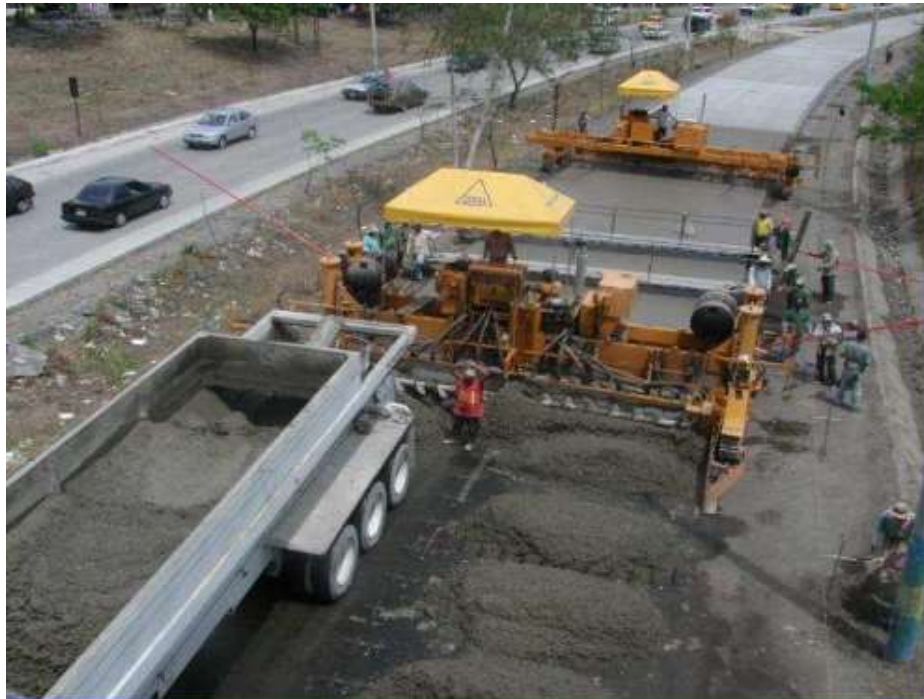
Figura 2.16 Colocación de pavimento rígido en la actualidad.
