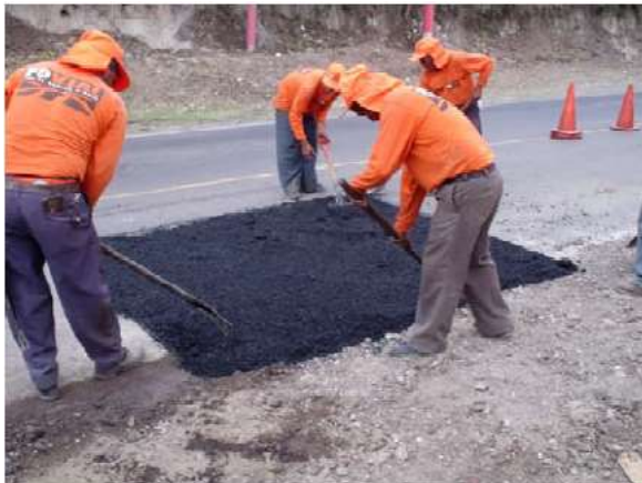
Figura 2.14 bacheo en carretera de concreto asfáltico.
