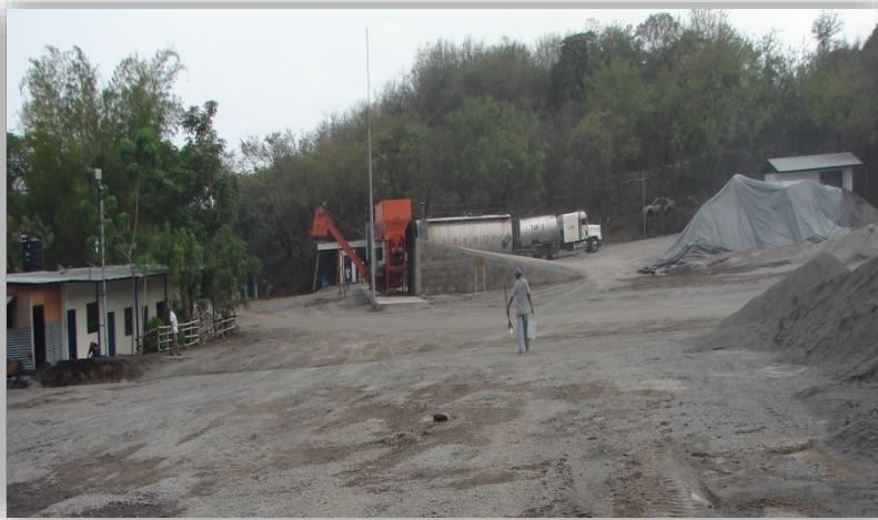
Ilustración 115. Instalaciones de la Pedrera La
