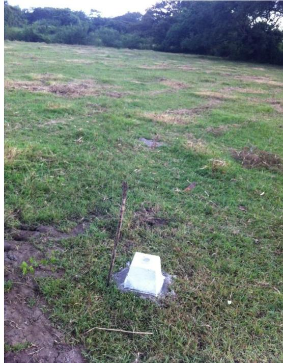
**Figura 6.10 Mojones de Vértice FMO5 y Marca Acimutal (MKZ) FMO6 ya terminados.**
