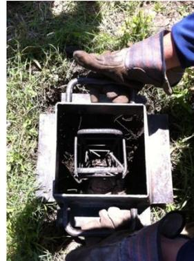
Luego se realizó la mezcla de concreto proporción 1:2:2 con cemento Portland para luego ser vertida dentro los moldes.
