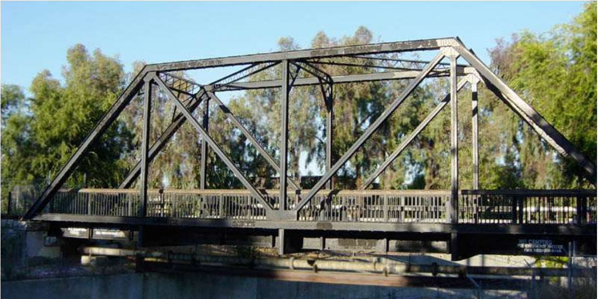
Figura 2-33. Puente de celosía, primeramente fabricado para el paso de ferrocarril, pero actualmente usado para soporte de tuberías y paso de peatones y bicicletas. Ubicado en California, USA.
