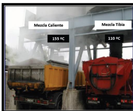
FIGURA. 3.19 Comparación de la Emisión de gases entre HMA y WMA
