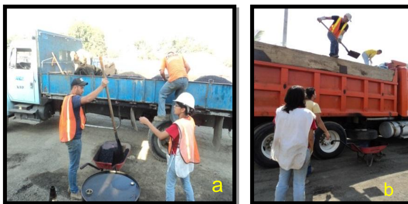
FIGURA 5.5 a) y b) Muestreo de mezcla asfáltica tibia.
