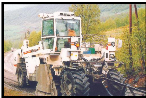
FIGURA. 3.26 Estabilización en sitio con asfalto espumado.
