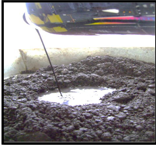
Figura 5.33 Emulsión asfáltica CSS-1h siendo agregada al RAP
