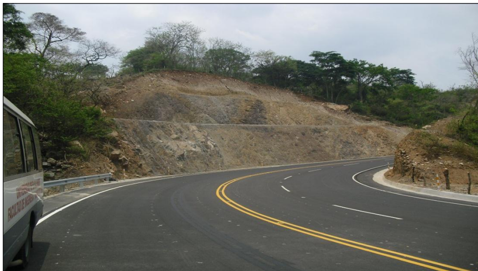
Figura 2.5 Tramo 2A de la carretera Longitudinal del Norte, El Salvador, Centroamérica, 2011.
