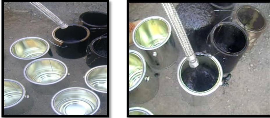
Figuras 5.59 Pruebas para poder controlar la cantidad de flujo de asfalto espumado.
