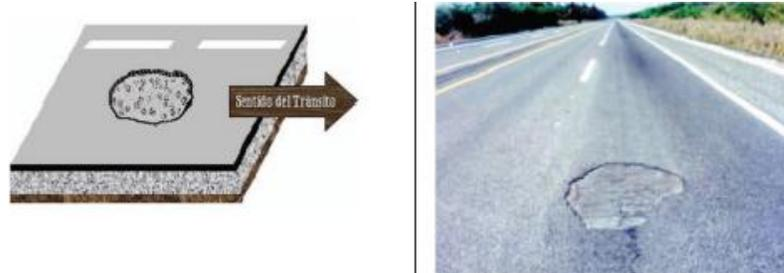
*Figura 3-19: Desprendimiento de capa de rodadura*
