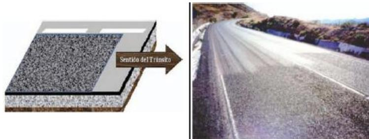
*Figura 3-18: Presencia de Agregados*
