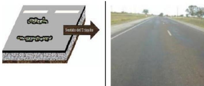
*Figura 3-20: Exudación del Asfalto*
