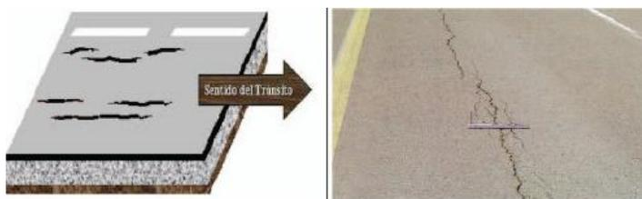
*Figura 3-9: Fisura Longitudinal*
