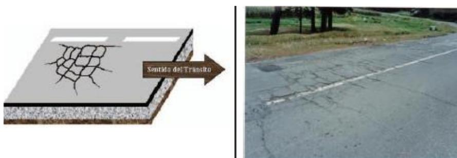
*Figura 3-6: Fisura en Bloque*
