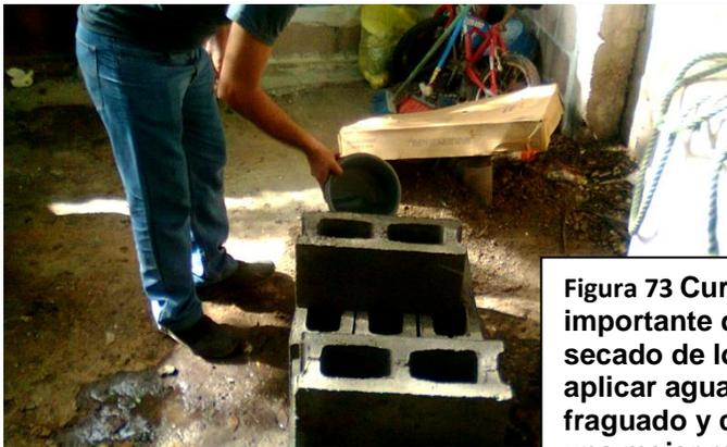
**Figura 73 Curado: Es importante durante el secado de los elementos, aplicar agua para un mejor fraguado y conseguir así una mejor resistencia.**
