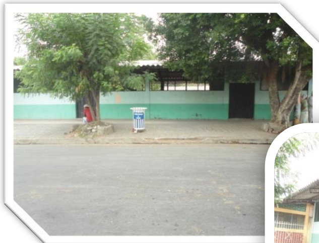
Foto # 01 Fachada Principal de Actual Casa Comunal
