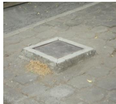
Foto # 19 Agua Potable
