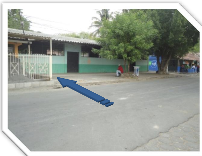
Foto # 07 Acceso Principal Actual Casa Comunal
