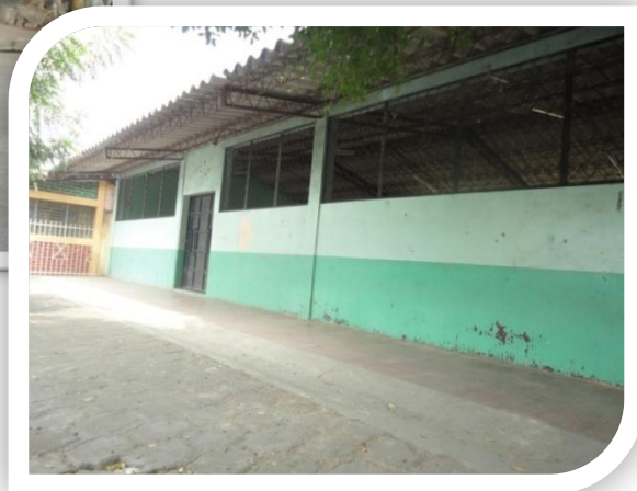
Foto # 02 Fachada Principal de Actual Casa Comunal
