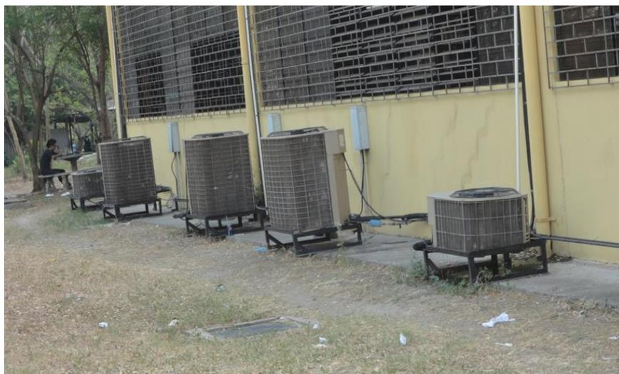
**Fotografía 3.5 Unidades condensadora de los equipos A/C de oficinas de Decanato y Sala de Reuniones.**
