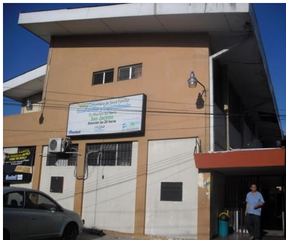
No hay establecido un punto de reunión en caso de sismos fuera de las instalaciones
