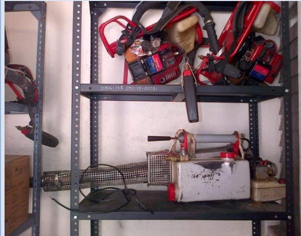
Equipos colocados en estantes sin protección
