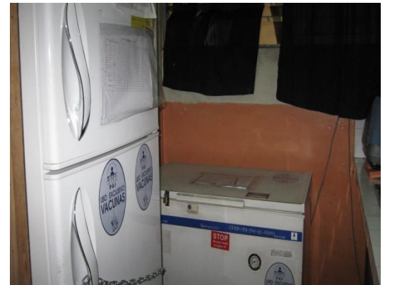
Refrigeradores sin control de temperatura
