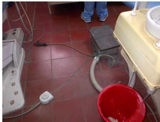
Cables sueltos que pueden provocar caídas
