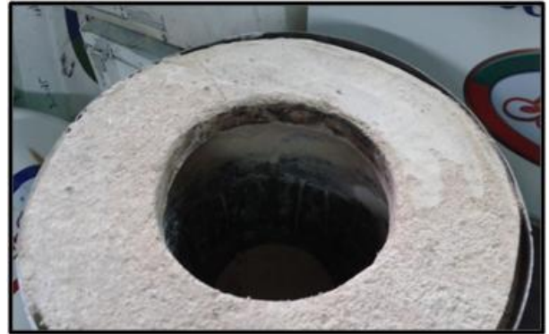
Fig. 3.23. Tapa refractaria colocada sobre estructura final de horno.
