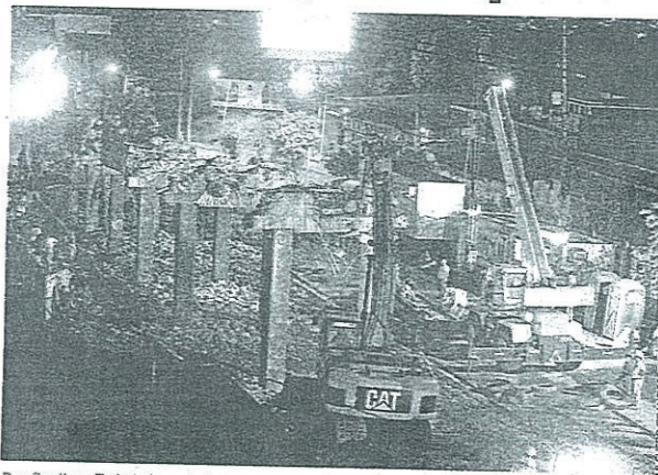
Por finalizar. Trabajadores de la empresa contratada por el VMT están concluyendo la demolición del paso a desnivel para iniciar la construcción de uno superior que cumpla normas internacionales.
