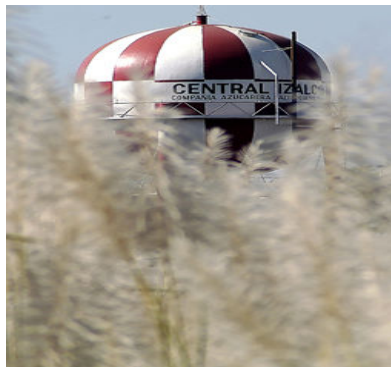
Ingenio Central Izalco descarga residuos contaminantes al río Ceniza.
