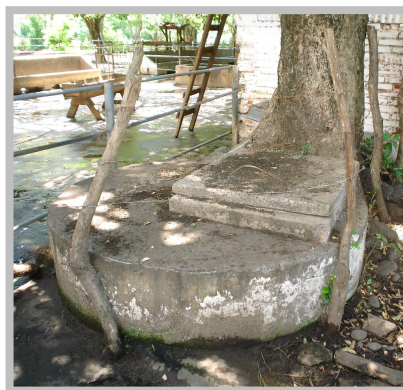
Foto 1. Detalle de uno de los pozos donde se extrae el agua para el uso y consumo en la hacienda.
