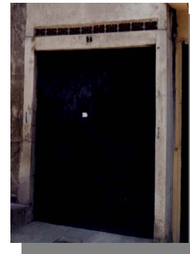
MANZANA F-2, INMUEBLE N° 17 Ubicación: 3° Calle Poniente.
