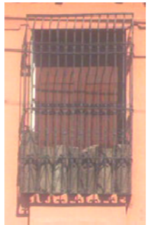
DETALLE DE VANO RECTO EN VENTANA DE MADERA DOS HOJAS Y BALCON CONCAVO DE HERRERIA
