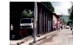
COSTADO 8. PERFIL SOBRE LA AVE. CRESCENCIO MIRANDA
