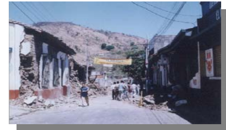
(Foto #15), DAÑOS SEVEROS EN EDIFICACIONES EN SISMOS 2001. Ubicación: Ave. Maria Cornejo.
