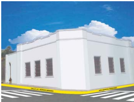
NOMENCLATURA PINTADA EN LOS CORDONES DE LAS ACERAS
