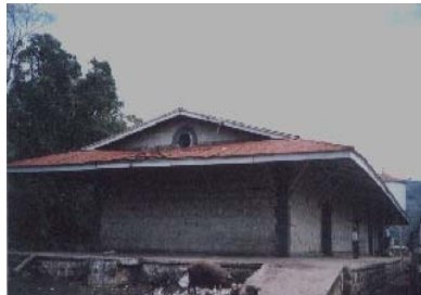
(Foto #13), ESTACIÓN DEL FERROCARRIL. Ubicación: Final de la 6ª Calle Poniente.
