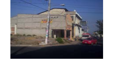
COSTADO 6, PERFIL SOBRE LA CALLE DR. JOSE CAÑAS
