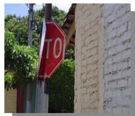
PASAJE VALDÉZ (Señalización en mal estado)
