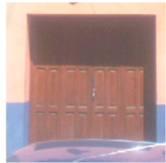
DETALLE DE ZAGUÁN DE VANO RECTO DE MADERA ENTABLERADA
