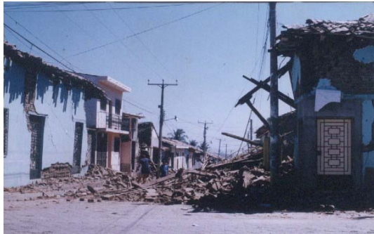
(Foto #16), DAÑOS PARCIALES Y SEVEROS EN VIVIENDAS.
