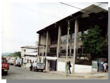
MANZANA A – 2, COSTADO NORTE Ubicación: Calle Antonia Galindo.
