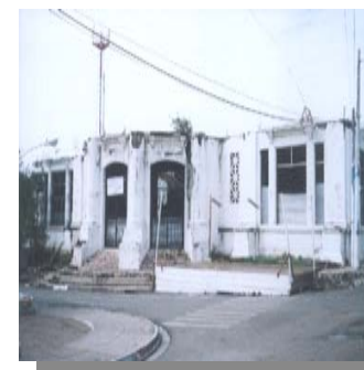
LA ALCALDÍA MUNICIPAL, ( En Ruinas ). Ubicación: Ave. María Cornejo y Calle Dr Díaz.
