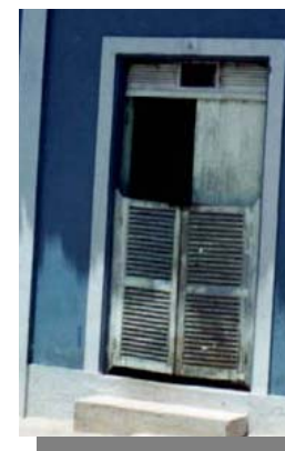
MANZANA F – 3, INMUEBLE N° 4 Ubicación: 3° Calle Poniente
