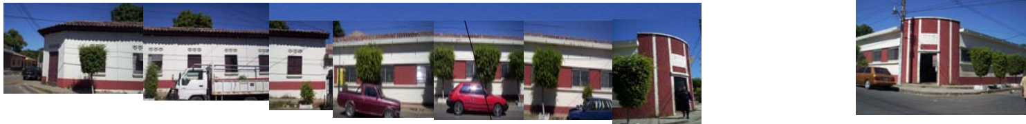
PERFIL PONIENTE SOBRE LA 8ª CALLE PONIENTE, MANZANA (CALLE DR. JOSÉ ROSA PACAS) G-5, PRESENTANDO UN PERFIL HOMOGÉNEO- HORIZONTAL
