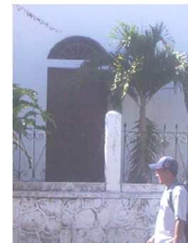
DETALLE DE PUERTA DE VANO DE ARCO DE MEDIO PUNTO Y TIMPANO, Y AL FRENTE JARDIN Y UN PASAMANO DE CONCRETO EN CHAPADO DE LAJA Y ENREJADO METALICO
