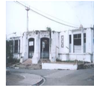
IGLESIA DE NUESTRA SEÑORA DEL PILAR Ubicación: Ave. Cresencio Miranda y Calle Dr. Diaz
