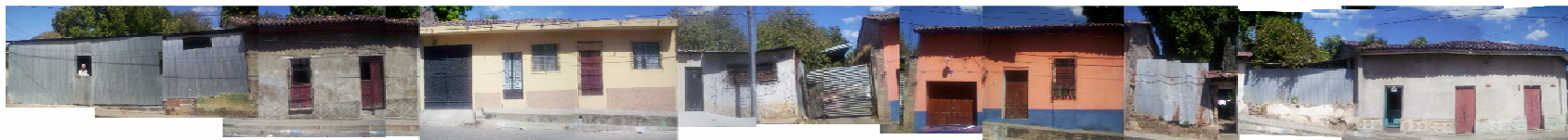
PERFIL SUR SOBRE LA CALLE JOSÉ SIMEÓN CAÑAS, MANZANA F-2, PRESENTANDO UN PERFIL HOMOGÉNEO- HORIZONTAL
