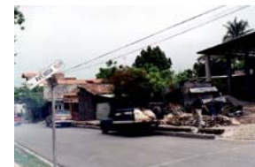
COSTADO 1. PERFIL SOBRE LA CALLE SERBELIO NAVARRETE
