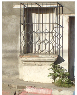
DETALLE DE VENTANA CON VANO RECTO , BALCON RECTILINEO CON DIBUJO Y ANTEPECHO
