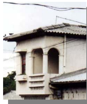
MANZANA A - 2 INMUEBLE N° 2 Ubicación: Calle Domingo Santos
