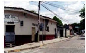
COSTADO 2, PERFIL SOBRE LA CALLE SERBELIO NAVARRETE
