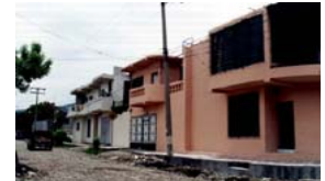
COSTADO 2, PERFIL SOBRE LA CALLE FELIPE ANGULO FIGUEROA
