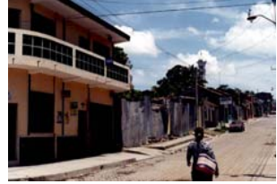
COSTADO 2, PERFIL SOBRE LA CALLE DOMINGO SANTOS
