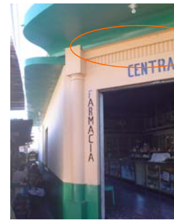
DETALLE LATERAL DONDE SE PUEDE VER ZOCALO PINTADO, NOTESE LOS VANO RESTO DE PUERTAS Y VENTANAS, DENTICULOS
