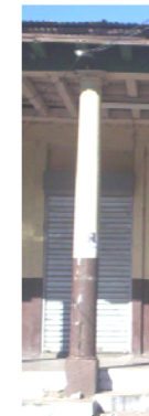
DETALLE DE COLUMNAS CIRCULARES DE MADERA CON CAPITEL TOSCANO
