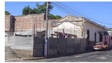
COSTADO 2, PERFIL SOBRE LA CALLE DOMINGO SANTOS
