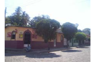
COSTADO 6, PERFIL SOBRE LA CALLE 1o. DE JULIO DE 1823 ORIENTE
