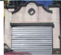
DETALLE DE ZAGUÁN Y EN LA FACHADA CUADRIFOLIO EN FORMA DE TREBOL Y PARAPETO QUE SIGUE LA MISMA FIGURA
