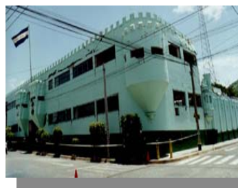
DESTACAMENTO MILITAR MANZANA D – 6, INMUEBLE N° 1 Calle Álvaro Quiñonez
