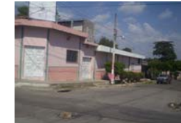
COSTADO 6, PERFIL SOBRE LA CALLE ALBERTO MERINO
