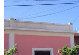
REMATE EN FACHADA CON PARAPETO Y CORNISA EN LA PARTE INFERIOR
