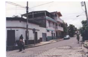
COSTADO 2. PERFIL SOBRE LA CALLE SERBELIO NAVARRETE
