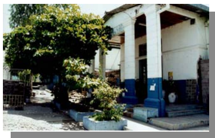
CENTRO ESCOLAR ANTONIA GALINDO, MANZANA E – 3, INMUEBLE N° 1 Ubicación: Calle Antonia Galindo.
