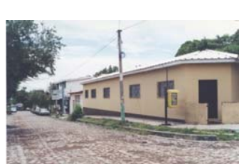
COSTADO 8, PERFIL SOBRE LA AVE. ESTEBAN HERNAN (5a. AVE. NORTE)
