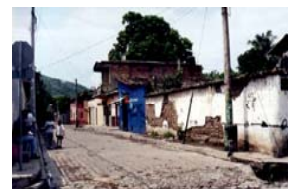
COSTADO 7. PERFIL SOBRE LA AVE. CRESCENCIO MIRANDA
