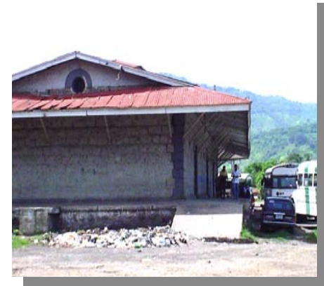
LA ESTACIÓN DEL FERROCARRIL HOY TERMINAL DE BUSES Ubicación: final Ave. Crescencio Miranda
