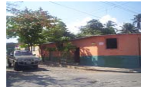
COSTADO 5, PERFIL SOBRE LA CALLE ALBERTO MERINO
