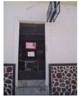
ZOCALO ENCHAPADO DE LAJA Y PUERTA DE VANO RECTO
