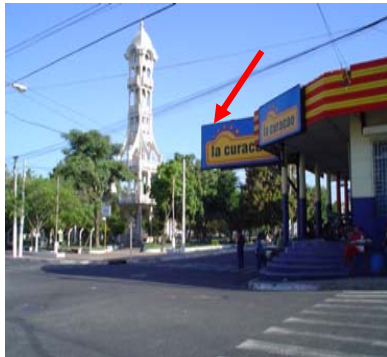
ROTULACIÓN A 90° MANZANA F – 3, INMUEBLE N° 1 Ubicación: Calle José Cañas y 4° Ave. Norte
