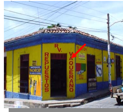
ROTULACION PINTADA MANZANA F – 3, INMUEBLE N° 1 Ubicación: Calle José Cañas y 4° Ave. Norte
