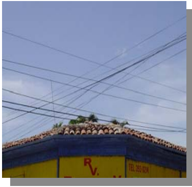
MANZANA F – 3, INMUEBLE N° 1 Ubicación: Calle José Cañas y 4° Ave. Norte
