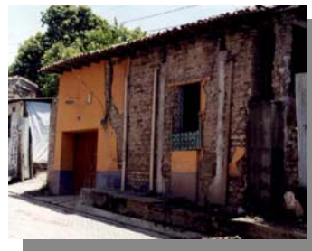
MANZANA F – 2, INMUEBLE N° 14 Ubicación:3° Calle Poniente
