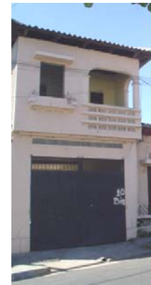
MANZANA A – 2, INMUEBLE N° 2 Ubicación: Calle Domingo Santos
