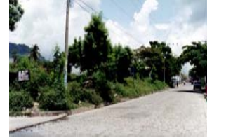
COSTADO 2, PERFIL SOBRE LA CALLE DR. CRISOSTEMO
