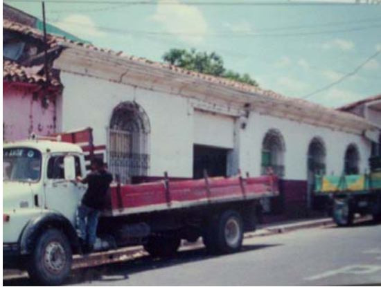
Inmueble que estaba ubicado en la Calle Licenciado Hernan Miranda y la Ave., Esteban Hernán, actualmente esta modificado
