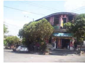
COSTADO 5, PERFIL SOBRE LA CALLE 1o. DE JULIO DE 1823 ORIENTE
