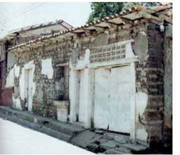
INMUEBLE MEDIANERO CON CUATRO VANOS RECTOS , DOS PARA PUERTAS, UNO DE VENTANA Y OTRO PARA ZAGUAN Y EN SU PARTE SUPERIOR CELOSIA DE BARRO. PAREDES DE ADOBE,
