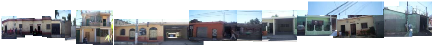
PERFIL NORTE SOBRE LA CALLE SERBELIO NAVARRETE, MANZANA G-4, PRESENTANDO UN PERFIL HETEROGENEO - HORIZONTAL
