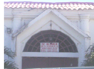
DETALLE DE TIMPANO EN ZAGUÁN DE ACCESO PRINCIPAL, POSEE MARCO MOLDURADO TERMINANDO EN LA PARTE SUPERIOR CON FORMA TRIANGULAR Y EN SUS EXTREMOS LATERALES DOS PILASTRAS CIRCULARES .
