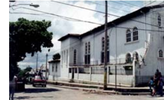
COSTADO 1, PERFIL SOBRE LA CALLE DR. CRISOSTEMO
