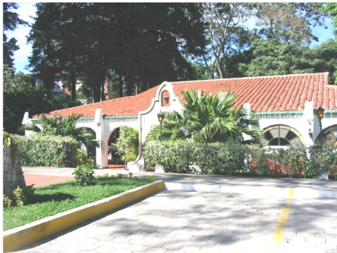
Fotografía N° 14 Vista de fachada
