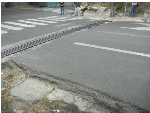
FOTO # 34 Canaleta Aguas Lluvias sobre Calle Turrialba
