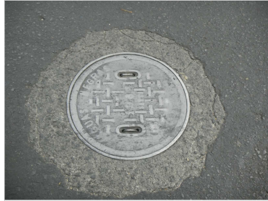
FOTO # 31 Pozo Aguas Negras sobre la Av. Alajuela
