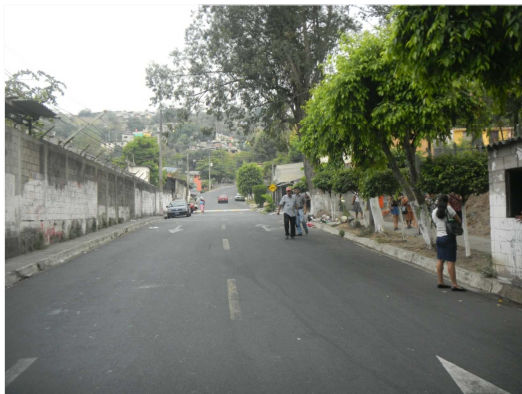
FOTO # 24 CALLE TURRIALBA - VIA SECUNDARIA
