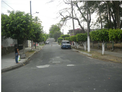
FOTO # 23 AVENIDA ALAJUELA - VIA SECUNDARIA
