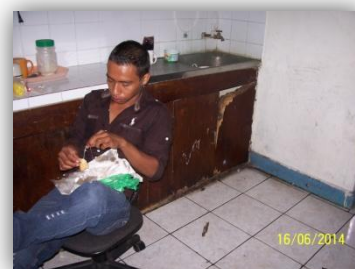
Fotografía 10: Cocina y comedor en condiciones insalubres
