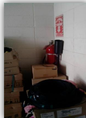
Fotografía 8: Equipo para instalación obstruyendo extintor y pasillo
