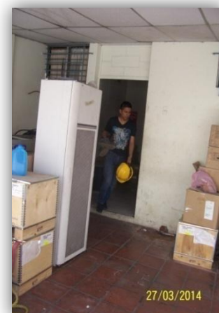
Fotografía 4: Puertas principales obstruidas por equipos de trabajo
