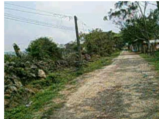
Imagen 62: Línea secundaria de energía Fuente: Elaboración Propia-Ues.
