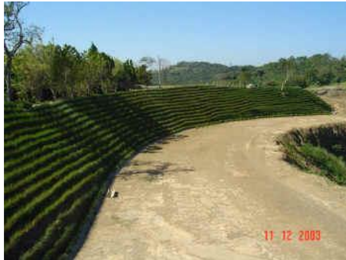
Estado actual, vista hacia el Occidente.
