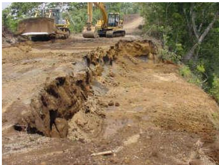
SECTOR CIMA DEL PARAISO. Remoción de grietas y conformación de terraza
