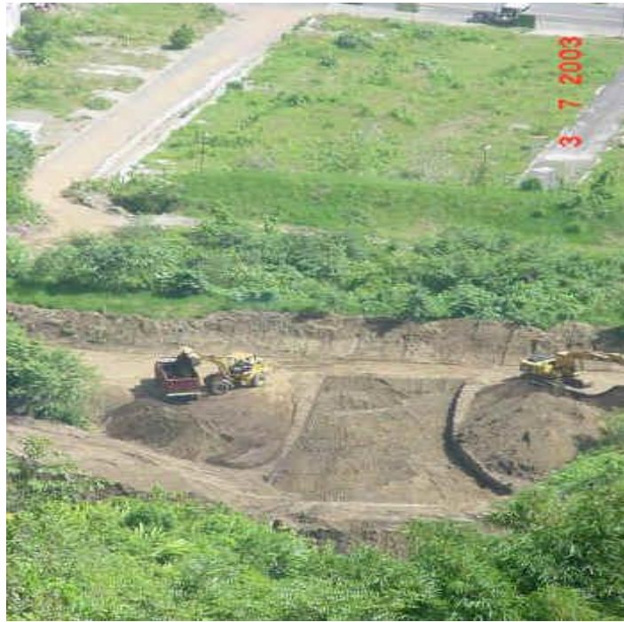
Limpieza de la piscina de sedimentación en la parte baja de Las Colinas.
