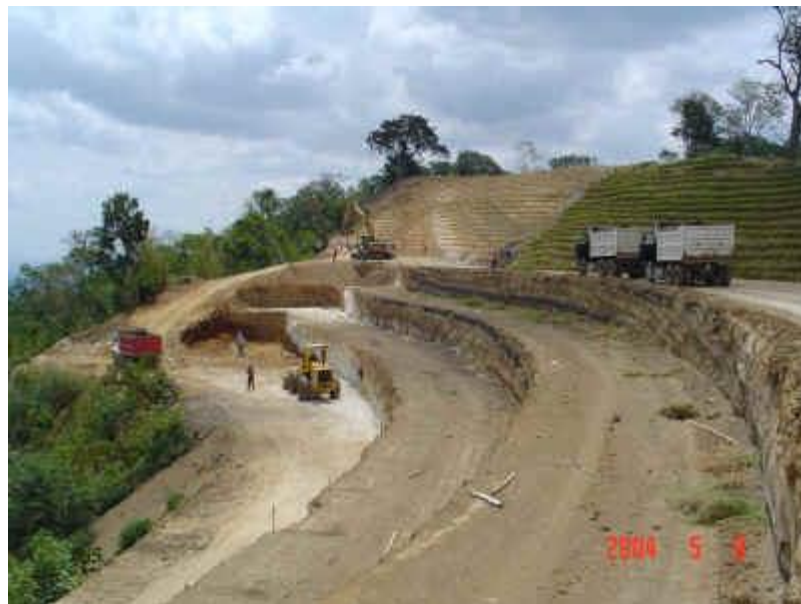
Foto 1. Estado del segundo talud
