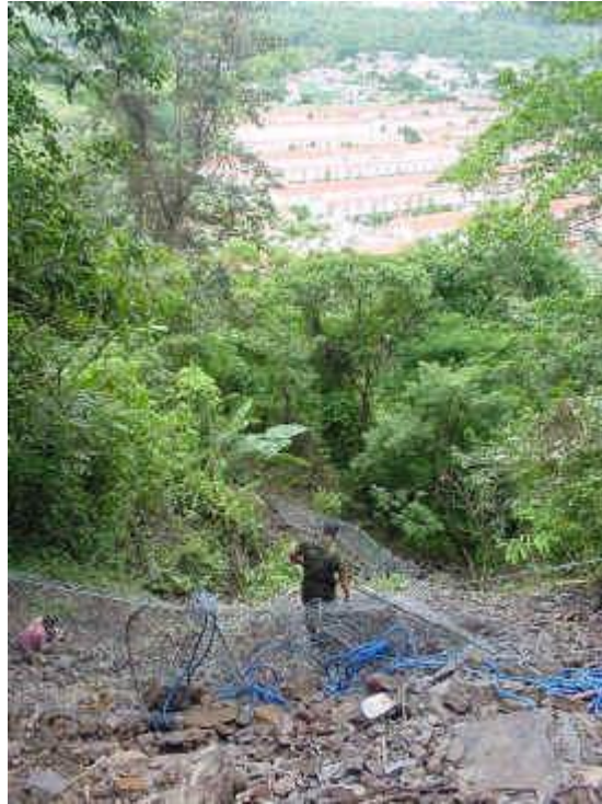
PINARES DE SUIZA. Vista general de la segunda y tercera red de protección.
