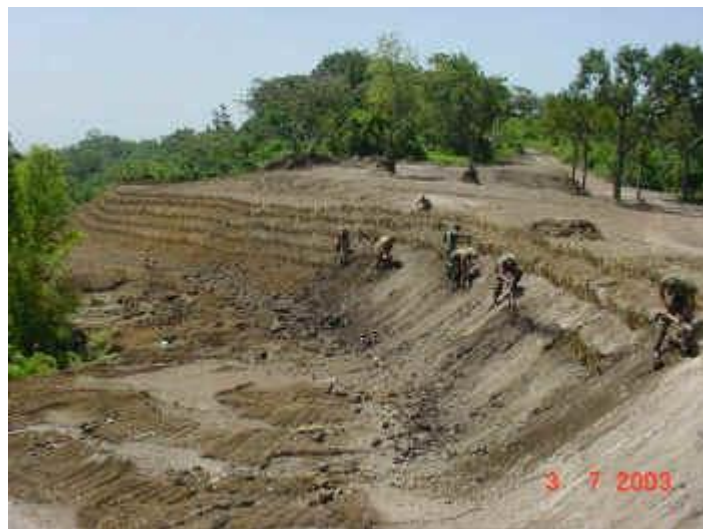
Limpieza de la piscina de sedimentación en la parte baja de Las Colinas.
