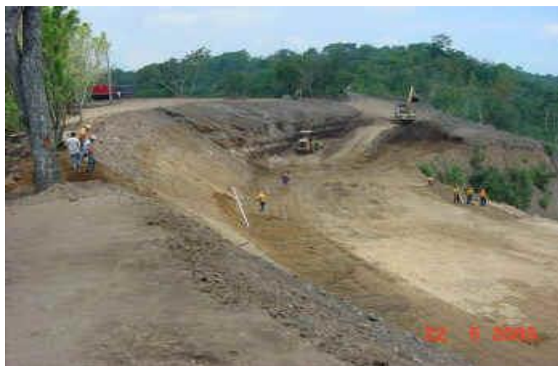
SECTOR LAS COLINAS. Panorámica general del avance de la obra.
