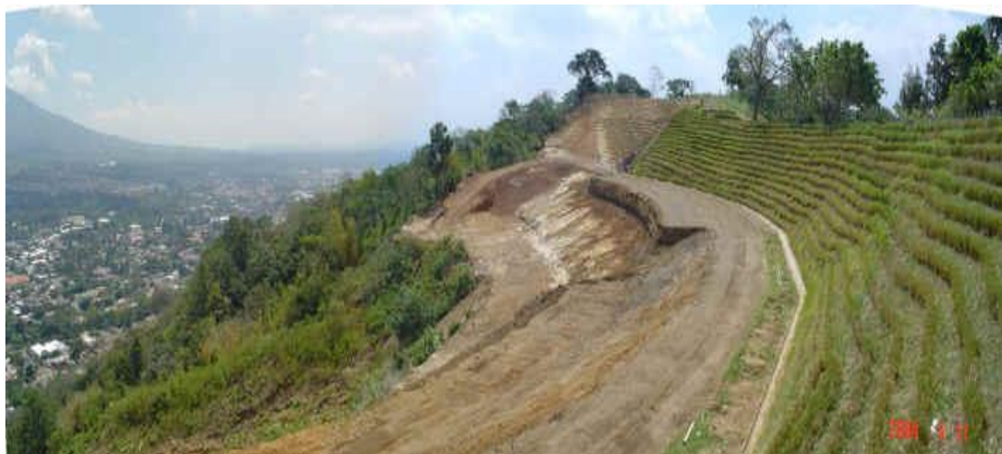
Vista panorámica del segundo talud
