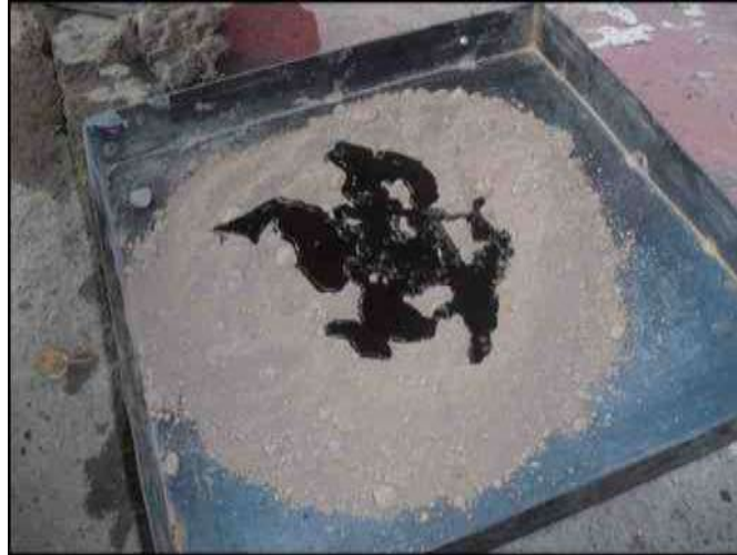
Fig. 3-16: Mezcla de Suelo, Emulsión y Agua
