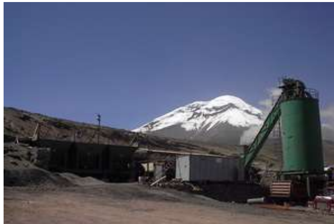
Fotografía 2.1 Planta de asfalto continua de flujo paralelo 18 .
