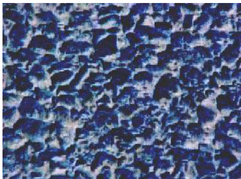
Fotografías 2.11. Textura superficial inadecuada en pavimentos asfálticos 28 .
