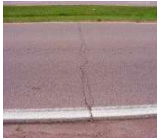
Fotografías 2.12. Agrietamientos y Fisuras en pavimentos asfálticos 29 .
