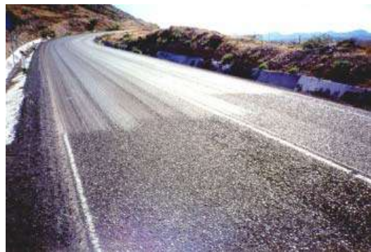
Fotografías 2.11. Textura superficial inadecuada en pavimentos asfálticos 28 .
