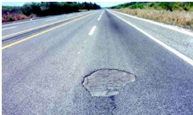
Fotografías 2.9. Segregación Transversal en Pavimento Asfáltico 26 .
