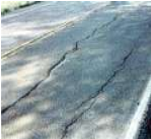
Fotografías 2.12. Agrietamientos y Fisuras en pavimentos asfálticos 29 .
