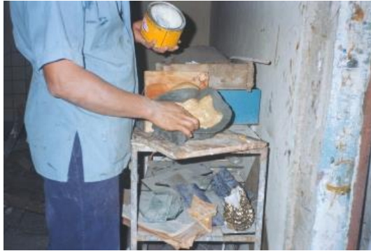
Fig. 4-4 Aplicación de aislante.
