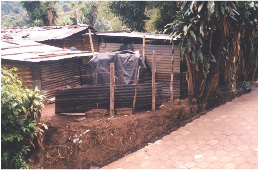
Foto 2: Viviendas del Cantón Las Grandillas.
