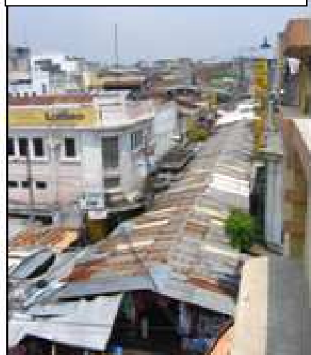
Sección peatonal sobre calle arce, entre 3ra y 5ta avenida. Tomada 11/05/07
