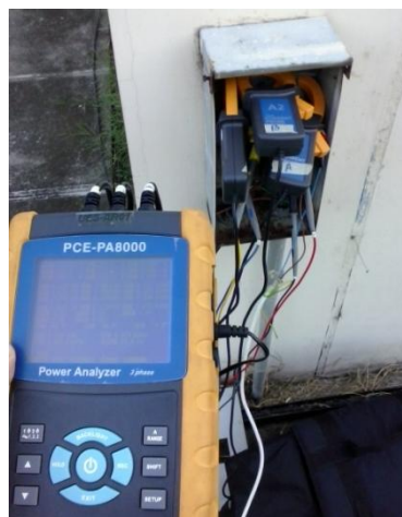
Figura 50 Medición de potencia eléctrica
