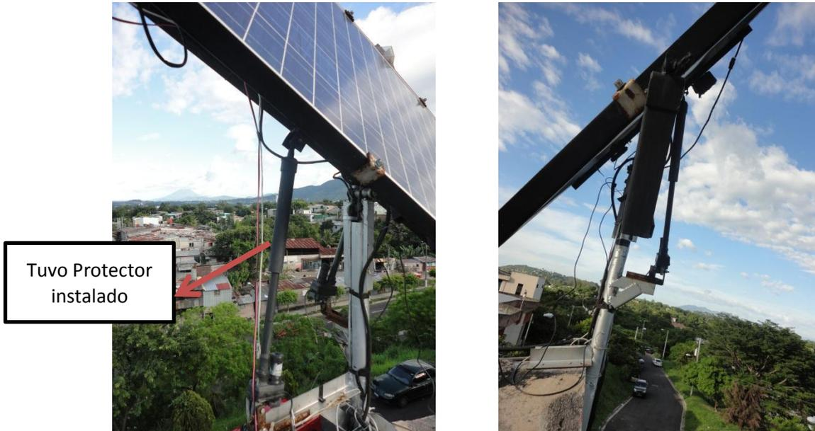
**Figura 1.4.** Actuadores lineales reparados e instalados, imagen izquierda movimiento (Norte-Sur) y viceversa, imagen derecha movimiento (Este-Oeste) y viceversa.
