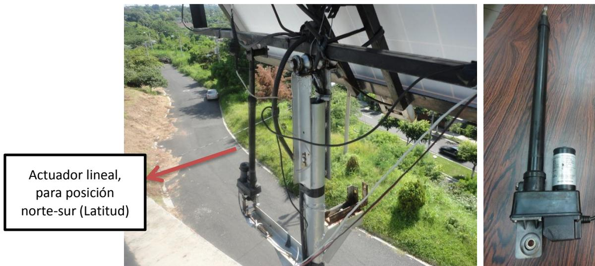
Figura 1.3. Actuador lineal instalados en la estructura mono-poste del SFV móvil.
