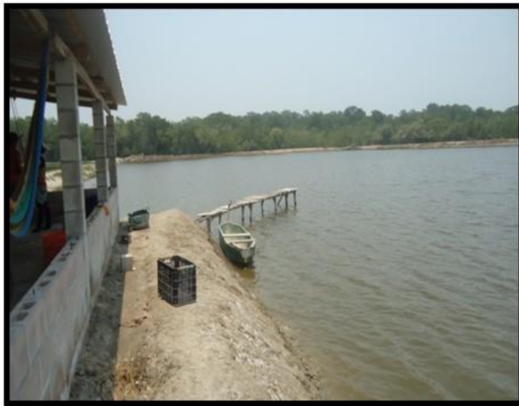
Ilustración 60 Caseta de vigilancia de estanques.
