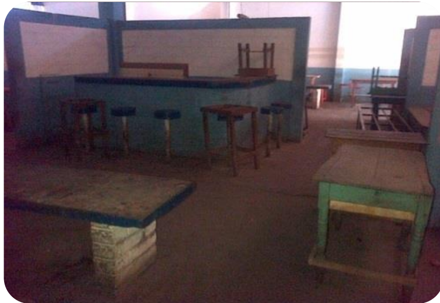
Imagen: N°4: Instalaciones del Mercado.
