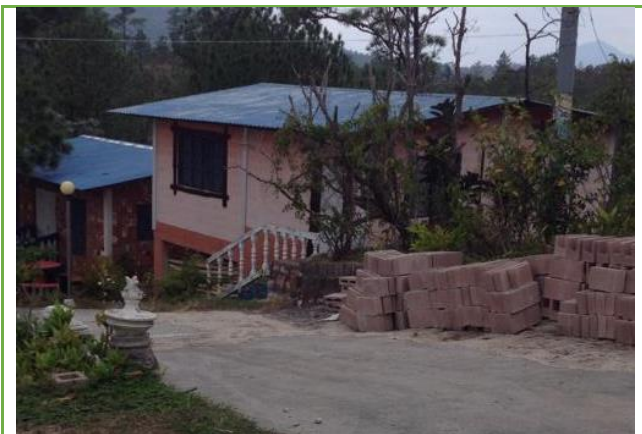
Imagen n°26: cabaña de bloques de concreto. Fuente: propia
