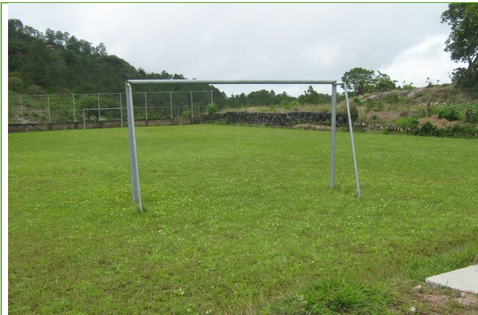
Imagen n°32: cancha de futbol y muro de retención. Fuente: propia
