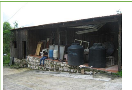
Imagen n°28: bodega. Fuente: propia
