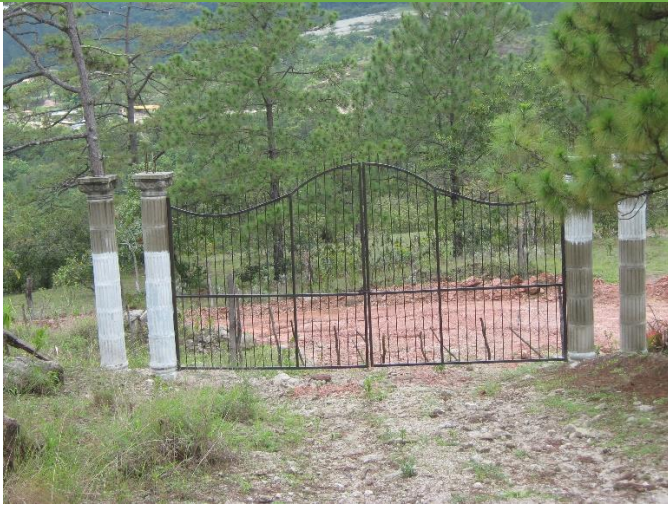
Imagen n°21: acceso secundario al terreno. Fuente: propia
