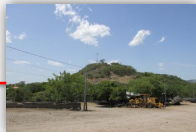
Infraestructura eléctrica y telefónica dentro del terreno.
