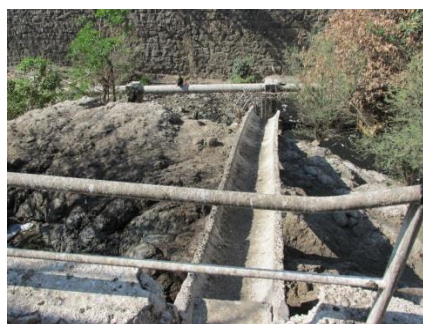
19 Zona Este, Quebrada El Cabildo
