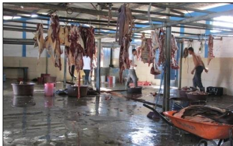
6 Vista interior, área de faenado Rastro Municipal.
