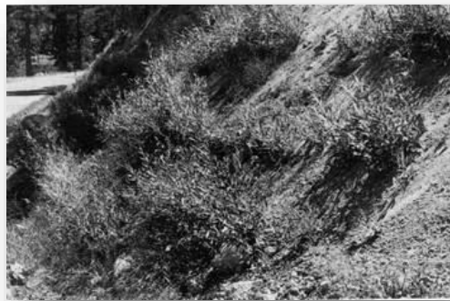
Figura 5.11 Construcción de empalizadas con fajinas de vegetación, de dos años, utilizando sauces.
