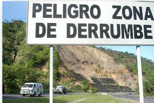
Figura 1.2 Deslizamiento en curva La Leona, carretera Panamericana (Febrero 2001).
