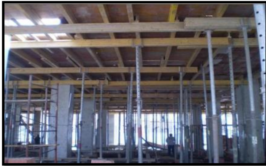
Figura 20: Encofrados metálicos. ( Alquiler de puntales metálicos Página web: olx.com ).
