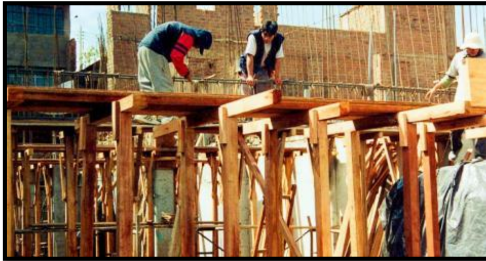
Figura 18: Encofrados de madera. ( Madera para encofrados, pagina web: civilgeeks.com ).
