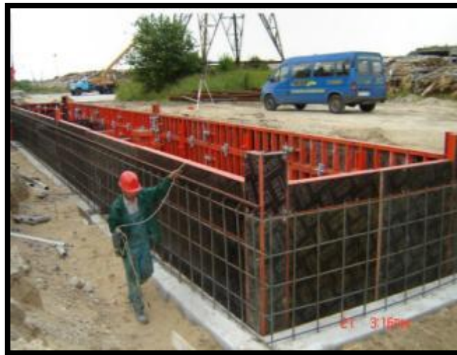
Figura 5: Encofrados en la Edad Contemporánea. ( Historia de los Encofrados y Evolución, Oscar Cid Repolles, Universidad Técnica de Cataluña, Barcelona España, mayo del 2010 ).
