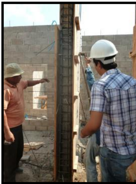
Figura 26: Encofrados para columnas en El Salvador. ( Construcción de casa habitacional de dos niveles en Riverside Gardens, San Miguel, El Salvador ).
