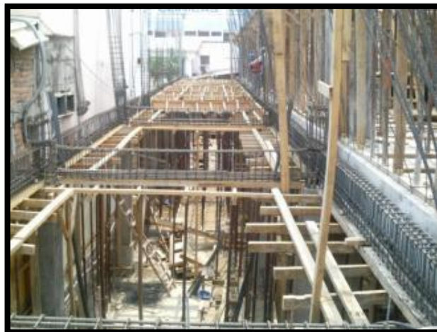
Figura 13: Encofrados empleados actualmente en la zona oriental de El Salvador. ( Construcción del hotel Trópico Inn, San Miguel ).
