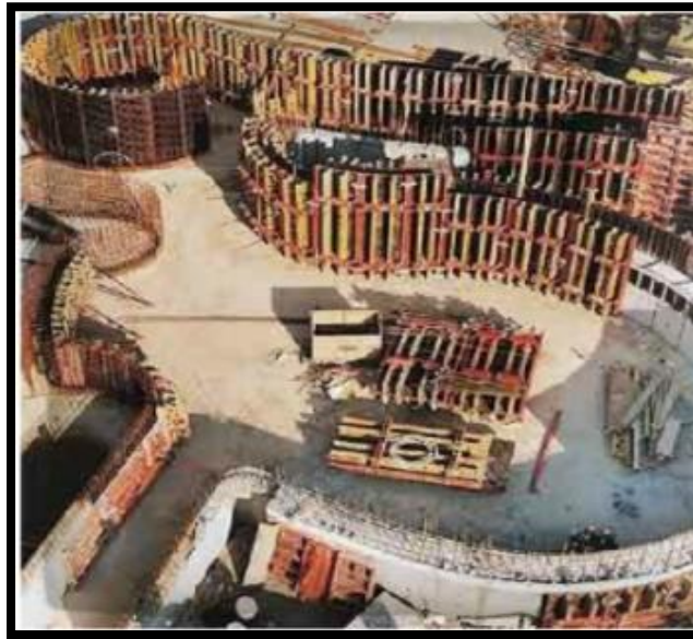
Figura 6: Sistema de encofrados mixtos, Edad Contemporánea. ( Historia de los Encofrados y Evolución, Oscar Cid Repolles, Universidad Técnica de Cataluña, Barcelona España, mayo del 2010 ).
