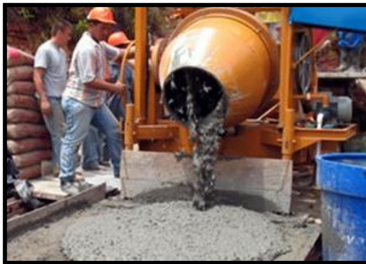
Figura 14: Componentes del concreto mezclando en concretera.
