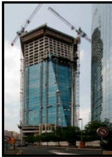
Figura 10: Sistemas de encofrados trepantes utilizados en la construcción de La Tour Granite. ( Estudio de Casos, HARSCO infraestructure ).
