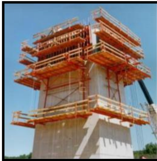
Figura 24: Encofrado de pila trepante. ( Encofrados Alsina, Madrid España ).
