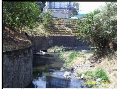
1 Muro de contención y talud margen izquierdo Carretera Panamericana
