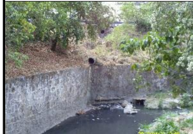
2 Muro de contención y talud margen izquierdo Carretera Panamericana
