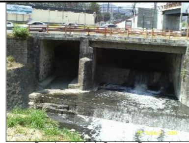
7 Bovedas debajo de Carretera Panamericana, cause de Quebrada El Piro
