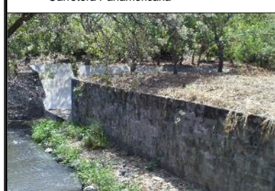
3 Muro de contención y talud margen izquierdo Carretera Panamericana
