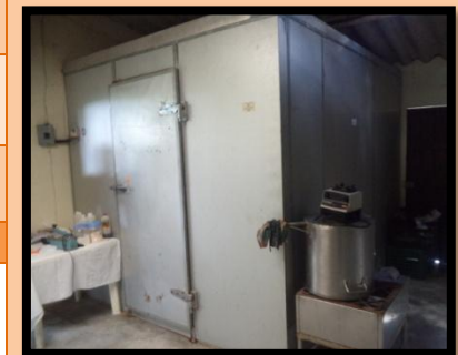
Lámina galvanizada esbozada y asilamiento en poliuretano de alta densidad. Enfriamiento por convección forzada
